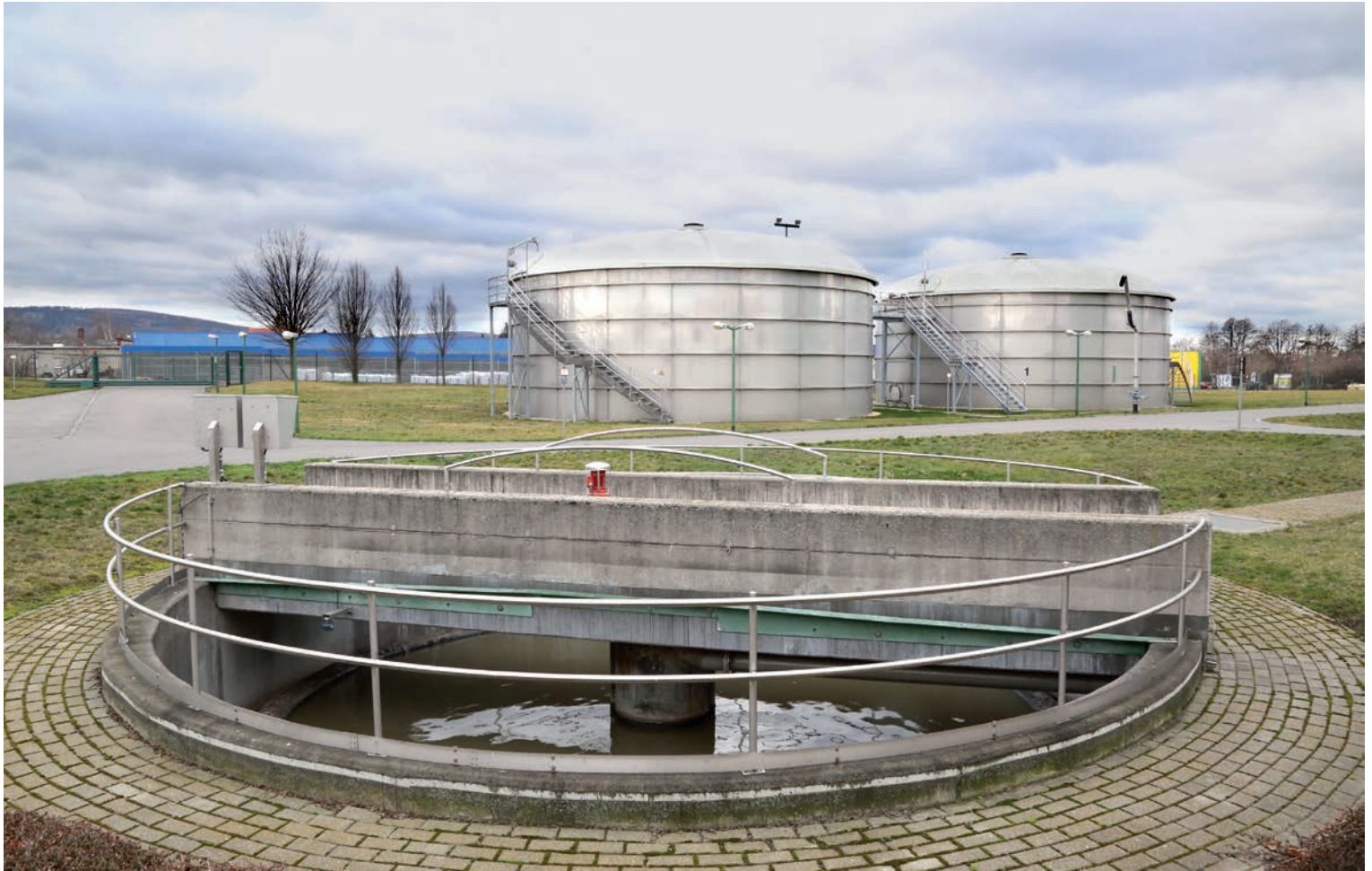
Kläranlage Bautzen, Eindicker und Schlammstapelbehälter
