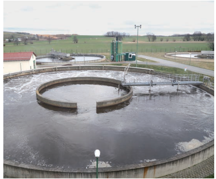
Kläranlage Bautzen, Belebungsbecken (vorn) und Nachklärung
